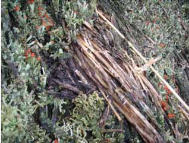
Bild 5: Reet mit Flechtenbefall ( Cladonia sp.)
