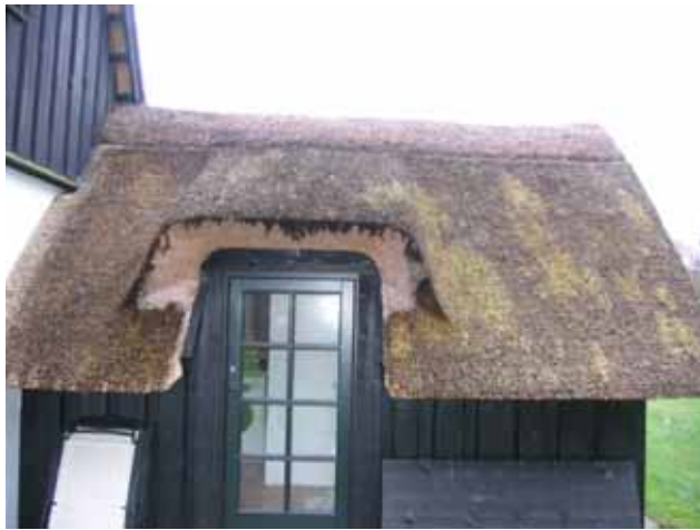
Bild 11 und 12: Neu gedeckte Reetdächer mit charakteristischen, gelblichen Flecken
