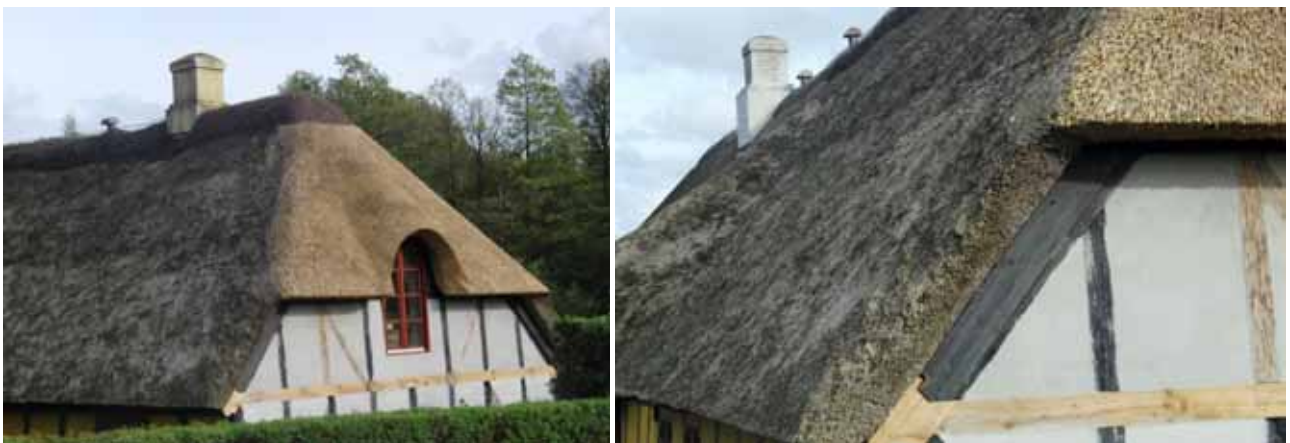
Bild 3 und 4: Instandhaltungsarbeiten an Reetdächern
