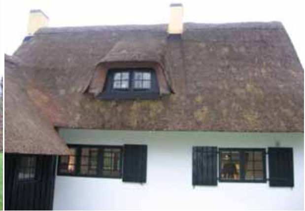
Bild 11 und 12: Neu gedeckte Reetdächer mit charakteristischen, gelblichen Flecken
